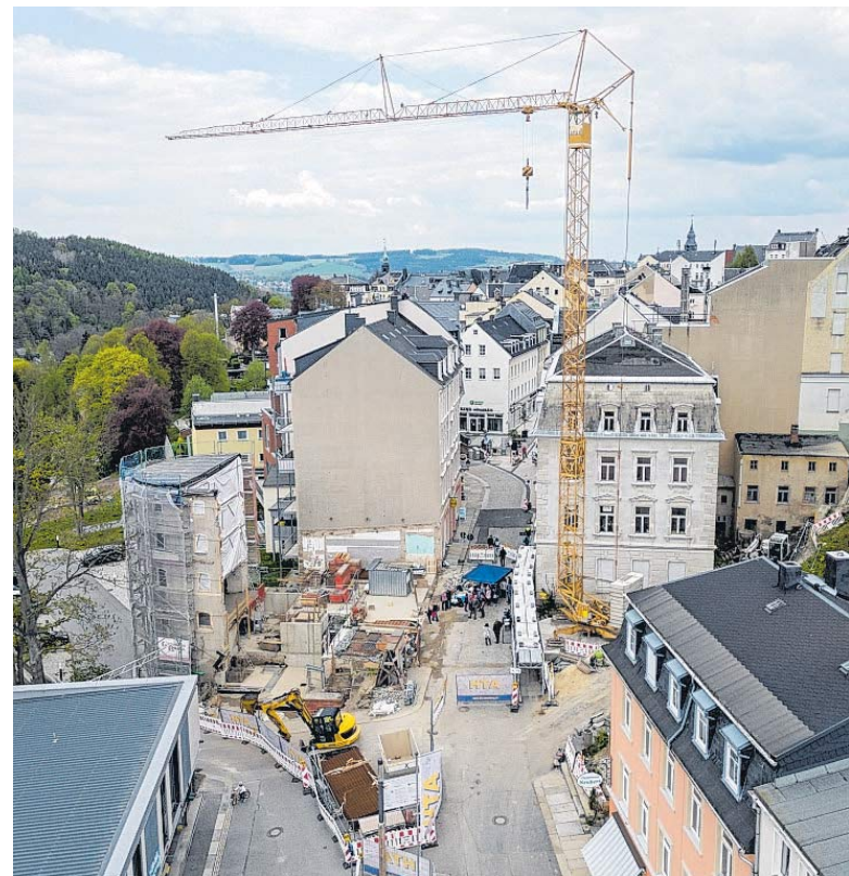
Der Abriss ist Geschichte. Geblieben ist nur der historische Wehrturm am Buchholzer Tor. Möglichst noch bis Jahresende soll der Rohbau der künftigen Herberge fertiggestellt sein.
